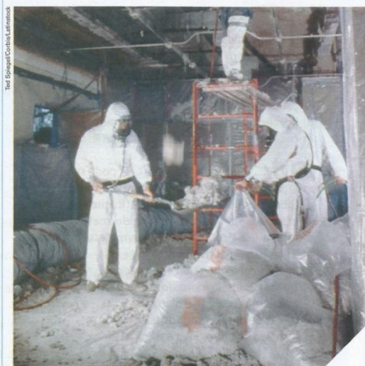
Equipe removendo amianto de um edifício comercial nos Estados Unidos da América em 1988.
