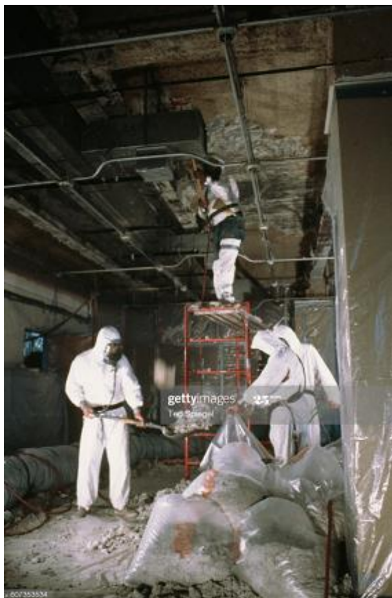
Figura 18: foto original dos trabalhadores removendo amianto de uma construção 47
